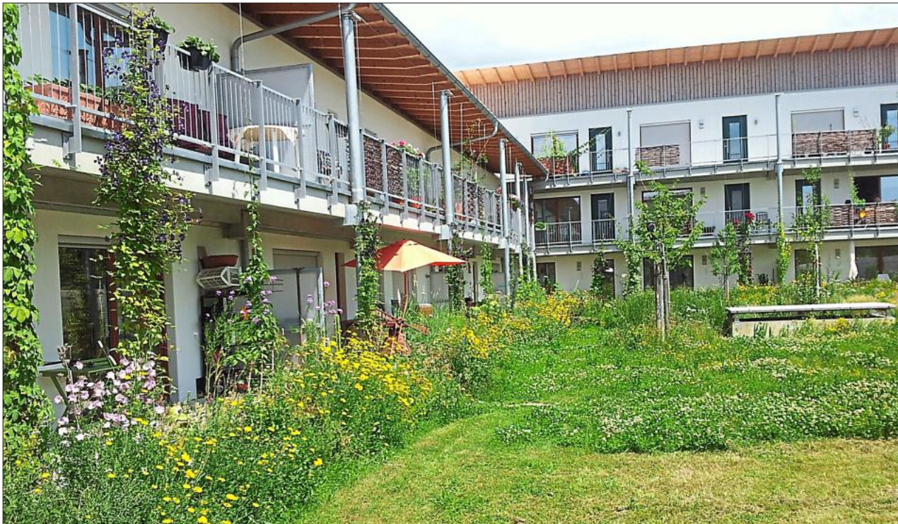
Für ihr „Haus mit Zukunft“ in Burgweinting hat die NaBau eG 2016 den Umweltpreis der Stadt Regensburg verliehen bekommen. Foto: NaBau
