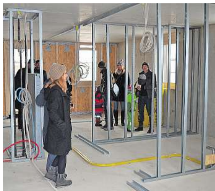
Noch ist das gemeinsame Bauprojekt eine Baustelle: Doch die Hausgemeinschaft ist nicht nur in den Planungsprozess eingebunden, sondern übernimmt auch beim Entstehen Aufgaben und Eigenleistungen. Fotos: Simon/NaBau
